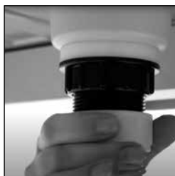
Figuur 23 vervangen afvoerslang.
