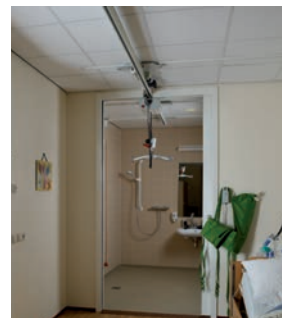
Monorail in combinatie met traverse-systeem.
