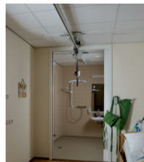
Monorail in combinatie met traverse-systeem.
